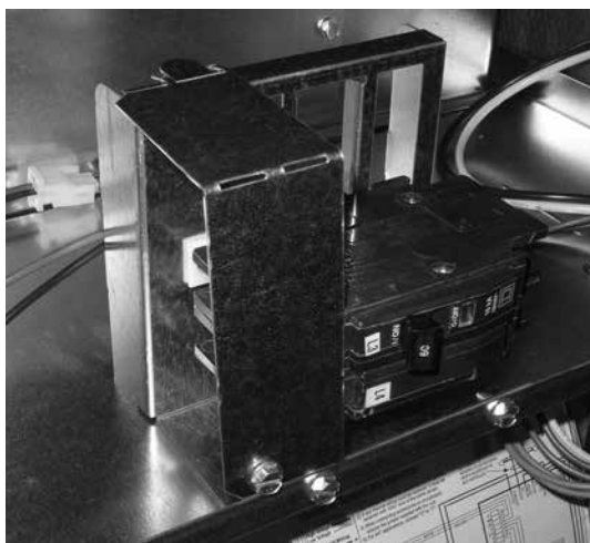
Figure 5. Couvercle d'évent installé
