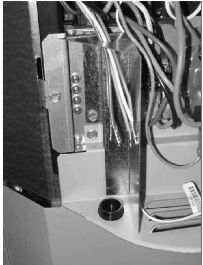
Figure 6. Compartiment basse tension pour câblage de commande
